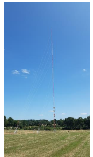
Mât de mesure Vicq-sur-Breuilh, installé en juillet 2023
